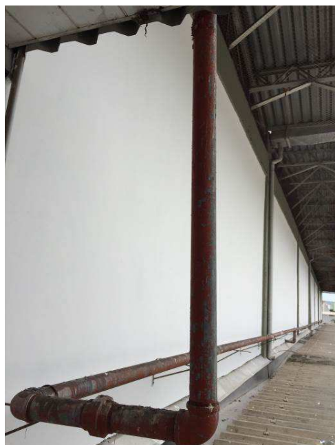
Figura 04 – Foto da tubulação externa que atende os hidrantes H1, H2, H3 e H4, e atenderá o hidrante H6.
