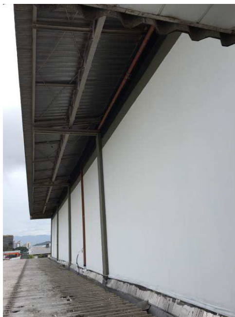
Figura 02 – Foto da tubulação externa que atende o hidrante H5.
