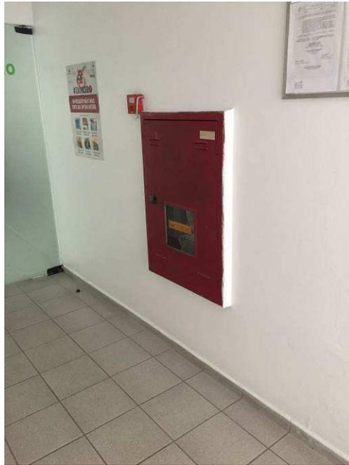
Figura 01 – Foto do hidrante H8.
