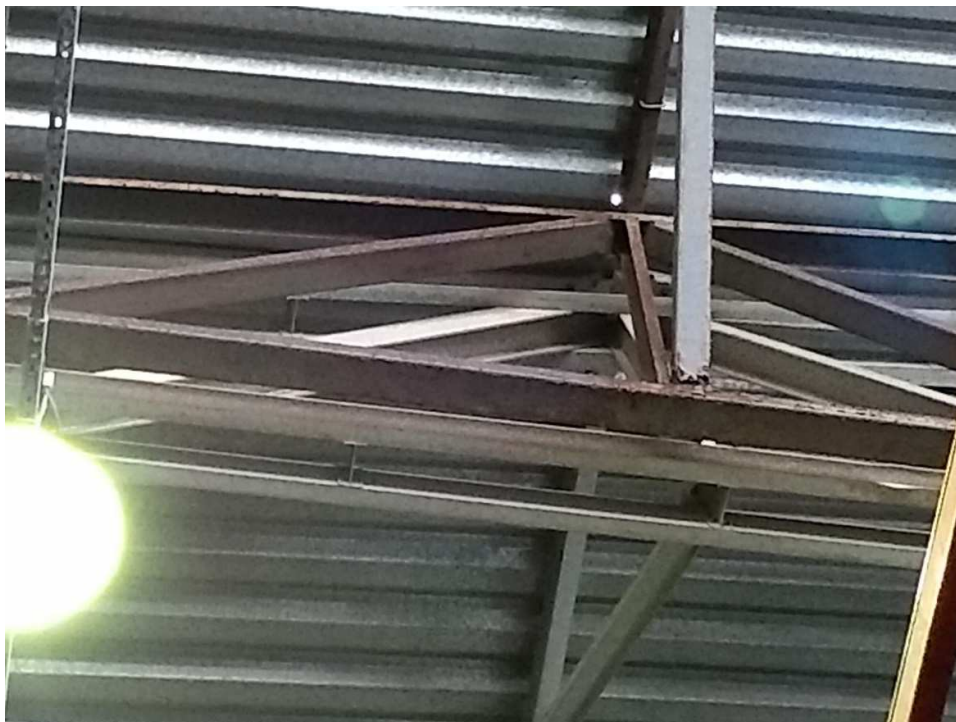
Foto 6 – Detalhe de estrutura metálica que deve ser recuperada
