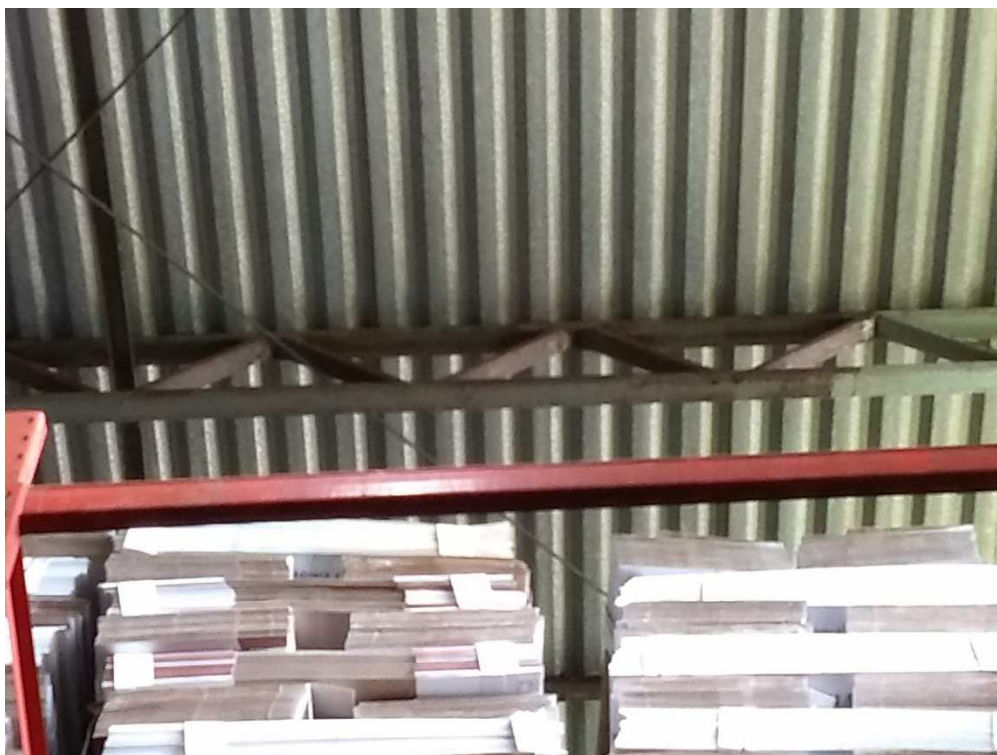
Foto 8 – Detalhe de estrutura metálica que deve ser recuperada (treliça)
