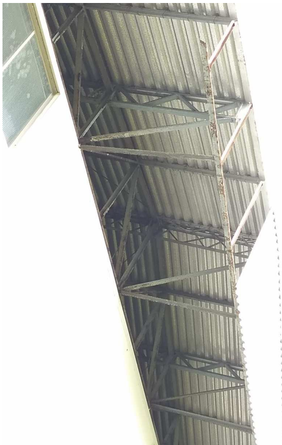
Foto 17– Local de colocação da platibanda e recuperação da estrutura metálica
