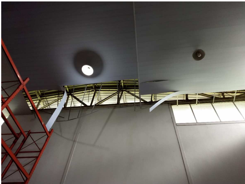
Foto 9 – Detalhe do forro que deve ser recuperado
