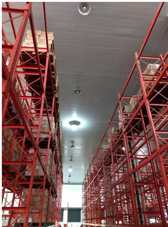
Foto 3 – Detalhe do forro que deve ser retirado e recolocado para manutenção da estrutura metálica
