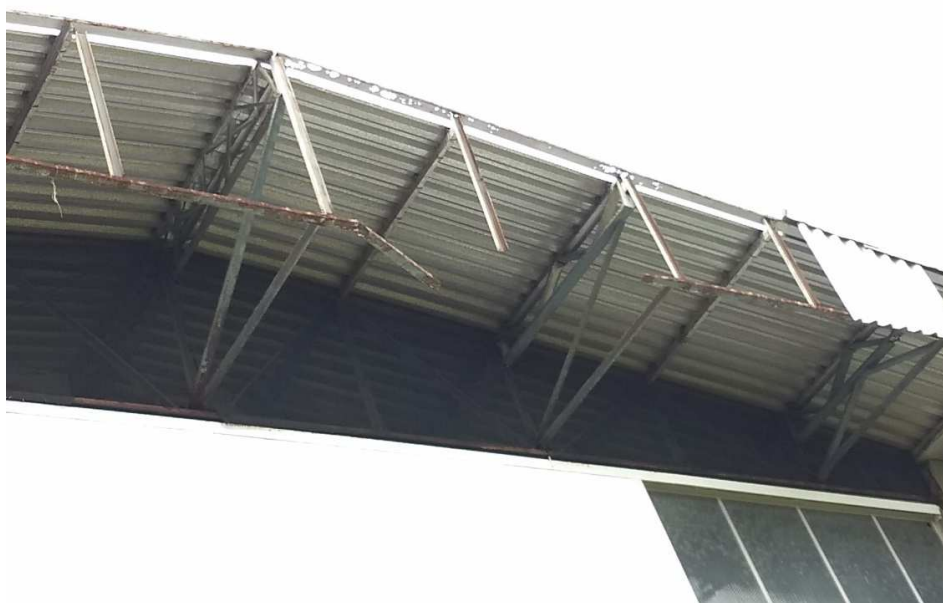
Foto 12– Detalhe de estrutura metálica que deve ser recuperada
