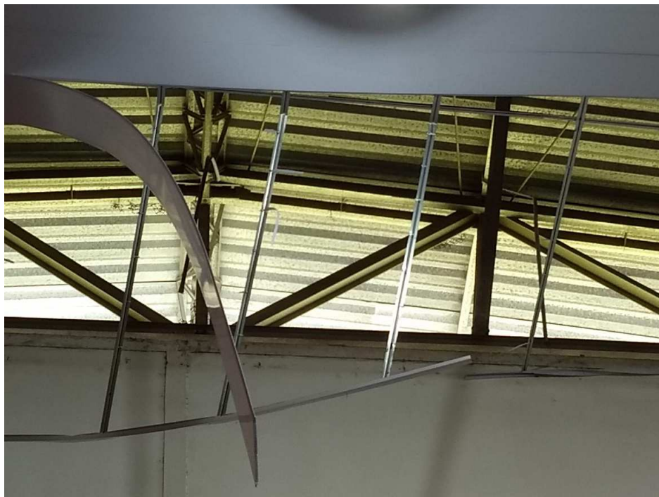
Foto 5 – Detalhe do forro que deve ser recuperado e de local onde deve ser aplicado a tela de barreira de animais
