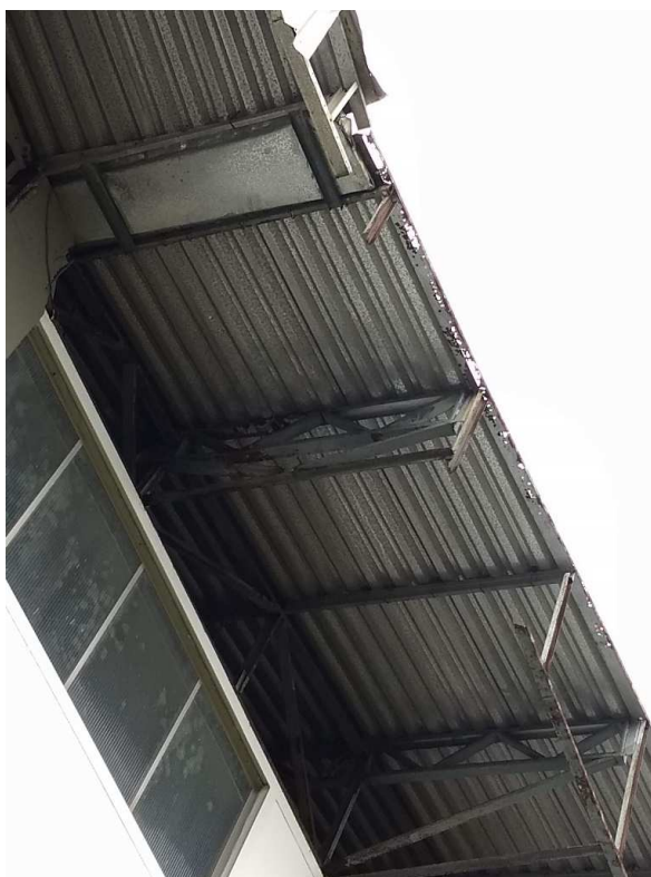
Foto 16– Local de colocação da platibanda e recuperação da estrutura metálica
