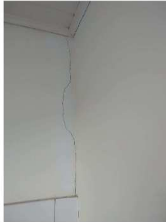
Demonstração de quantas rachaduras há no imóvel
