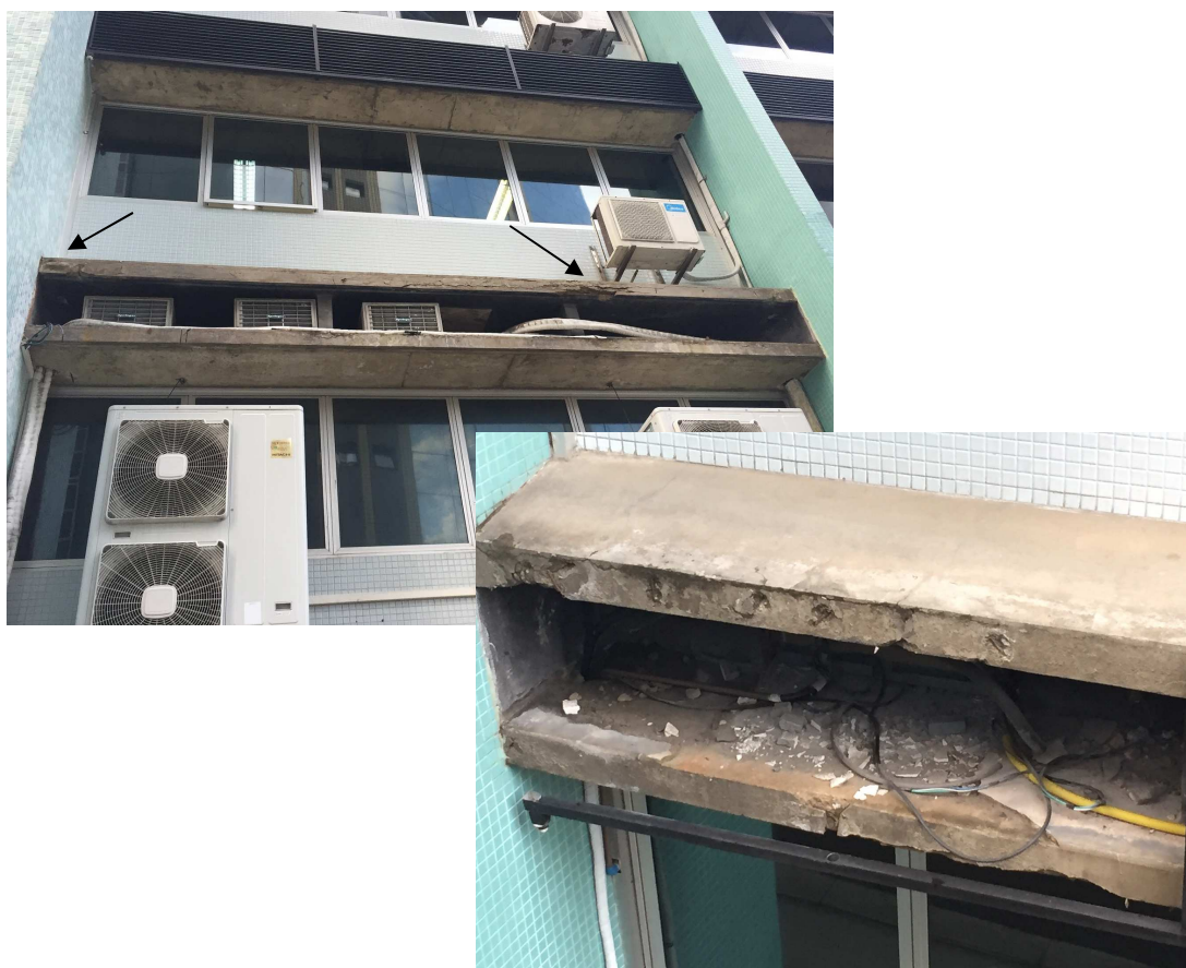
Imagem 05 – Elementos de concreto com patologia identificada na fachada da edificação
